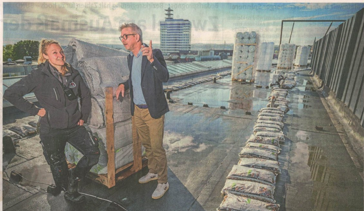
Zimmermeisterin Anna Bödeker und Stadthallenmanager Stephan Kipp begutachten auf dem Dach der Stadthalle die Baustelle. Fotos: Thomas F. Starke
