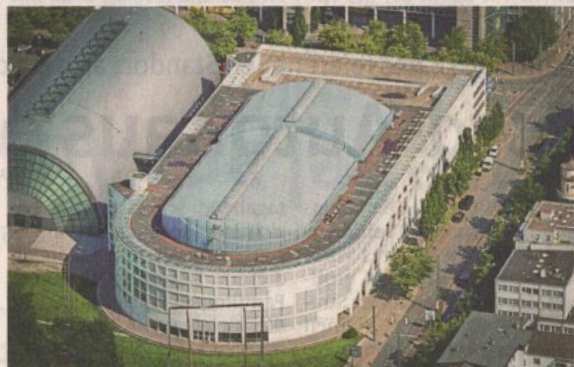
2000 Quadratmeter groß ist das Dach der Stadthalle. 1800 Quadratmeter werden begrünt.
