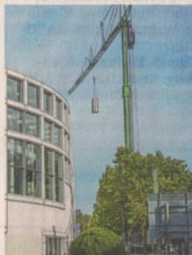
Ein Kran schafft 60 Tonnen Material auf das Dach.
